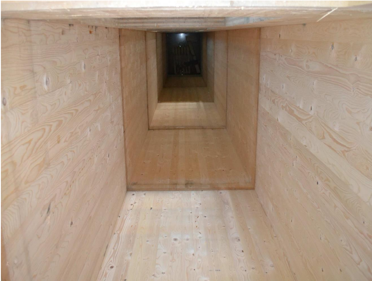
Cage d'ascenseur en CLT
